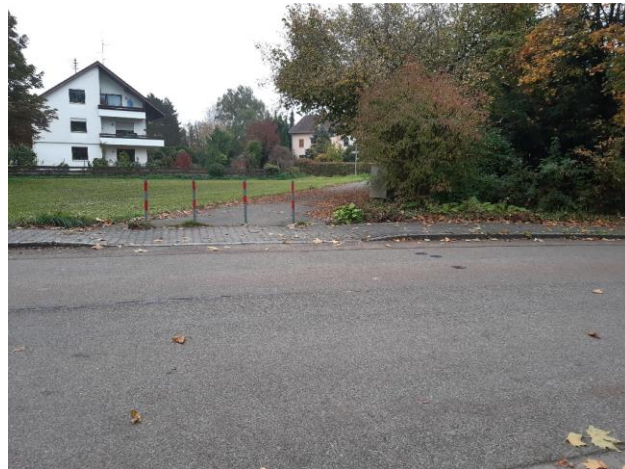
Ungesicherter Poller ohne Warnmarkierung
